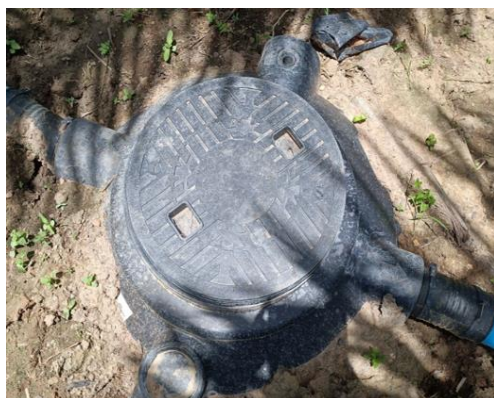
ภาพที่ 2-13 ถังบำบัดน้ำเสียสำเร็จรูป บริเวณพื้นที่ก่อสร้าง
