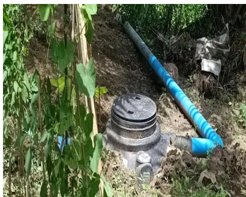
ภาพที่ 2-13 ถังบำบัดน้ำเสียสำเร็จรูป บริเวณพื้นที่ก่อสร้าง
